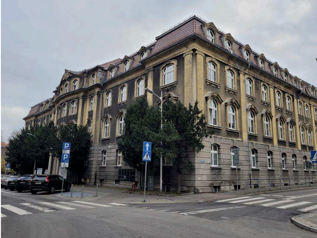
RYS. 6 WIDOK –NAROŻNIK – SKRZYŻOWANIE ULIC POWSTAŃCÓW I LOMPY
